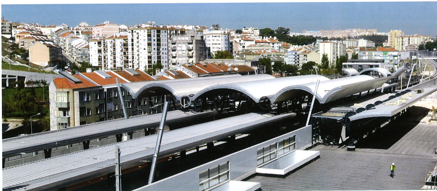
Vista da área de implantação e das coberturas. Station canopy and construction area.
