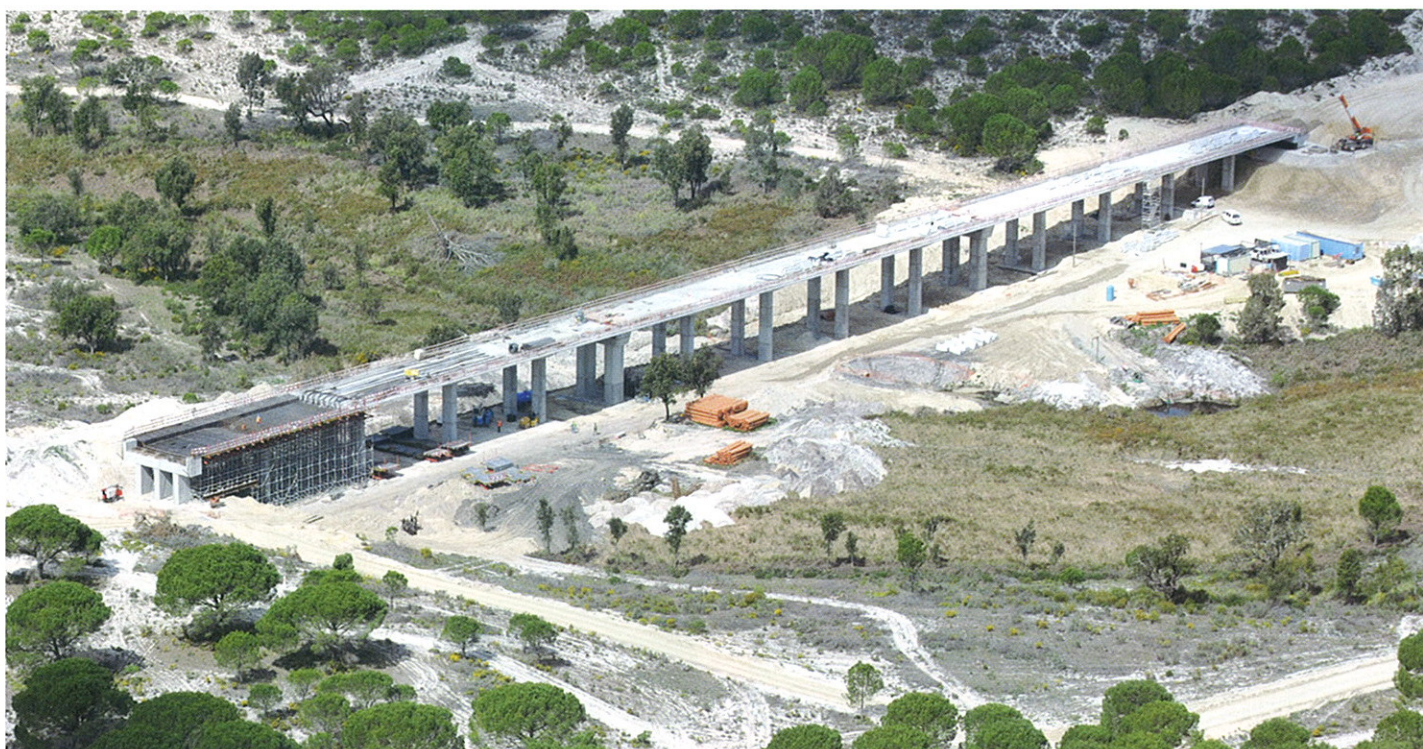
Execução do último vão. Last span construction.
