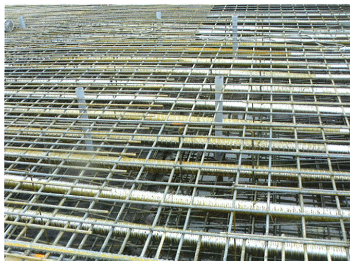
Armaduras e bainhas de pré-esforço da laje. Slab reinforcement grid and prestress corrugated steel duct.
